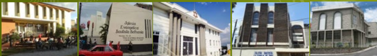
Zona 11, Gt (Ing. Bendfeldt); Zona 5, Gt. (Arq. Díaz); Zona 18, Gt. (Arq. Perdomo); Zona 21, Gt. (Arq. Díaz); Valle del Sol, Mx. (Pr. Samol)
